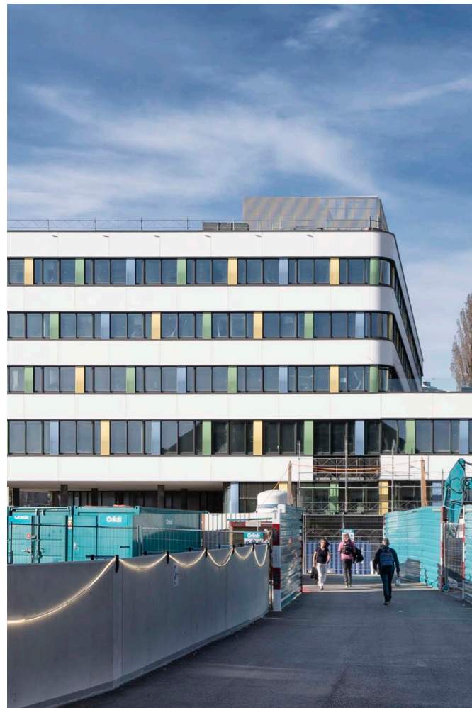
Le nouvel Hôpital des enfants ouvrira ses portes en 2025 au cœur de la cité hospitalière du CHUV.
