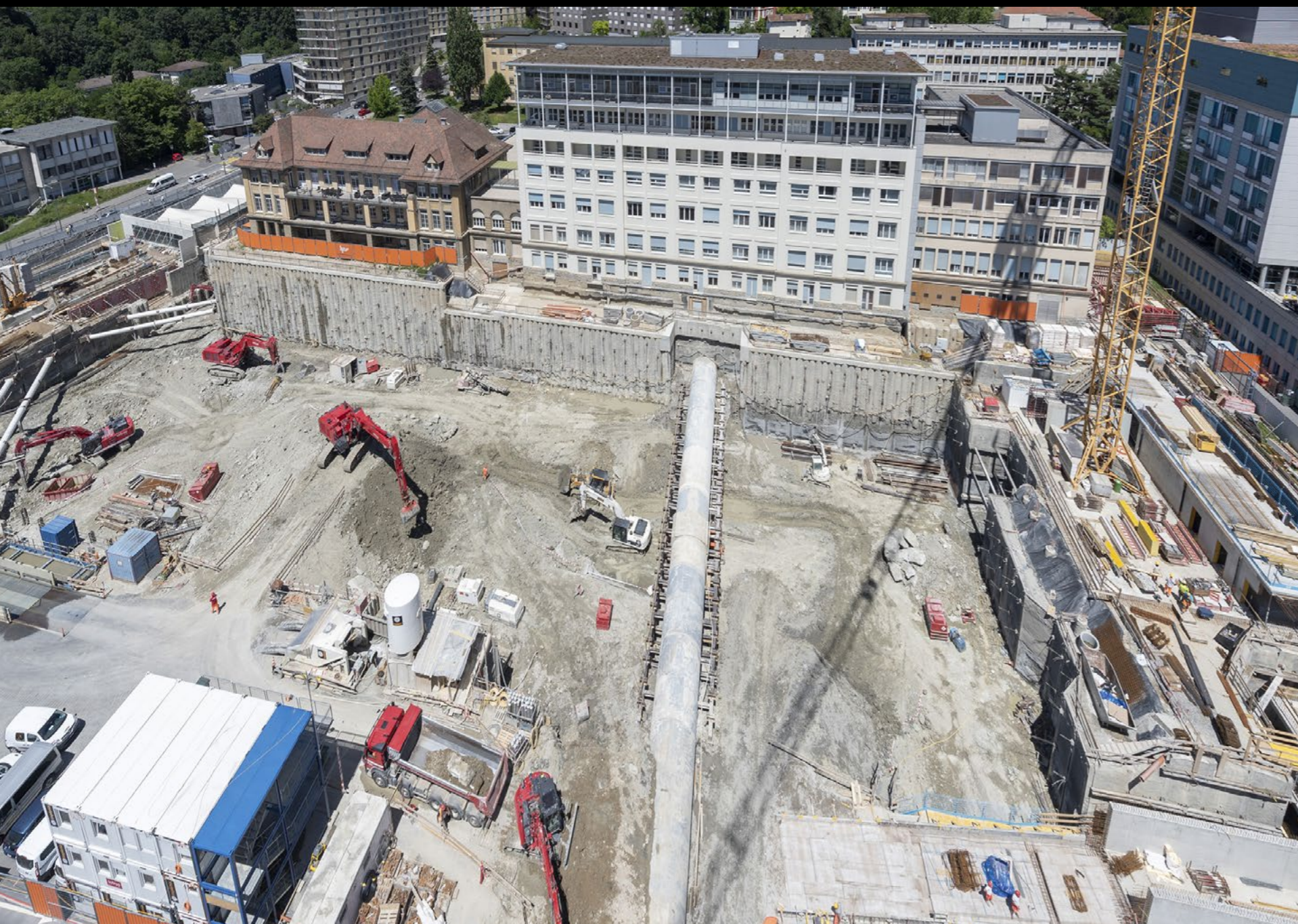
Différentes étapes (excavation, terrassements, gros œuvre) de la construction de l'Hôpital des enfants entre 2019 et 2021 © Gilles Weber / CHUV
