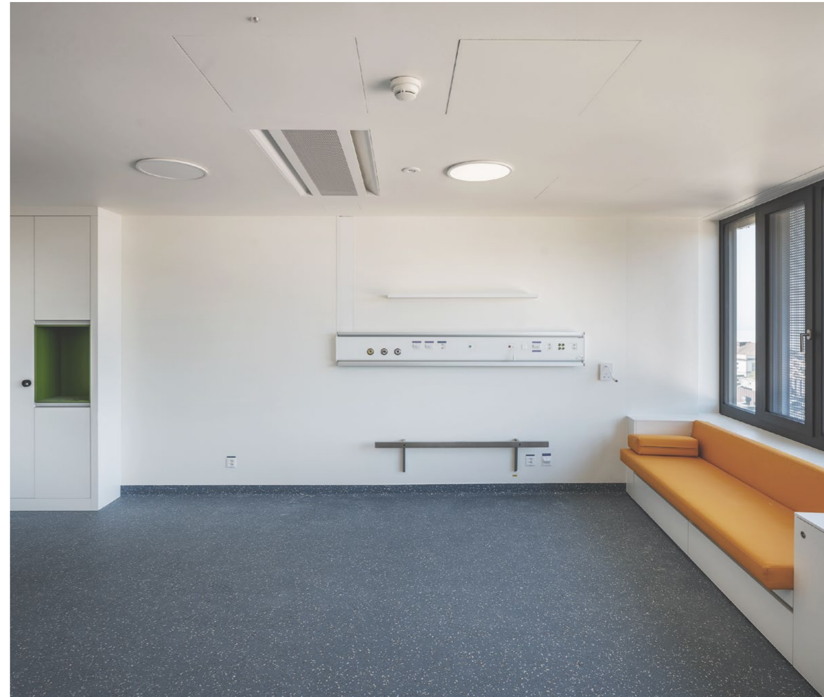
Les chambres dans les unités d'hospitalisation Photo ci-dessus © Jeanne Martel / CHUV
