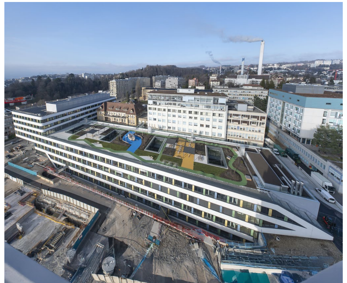
Prises de vue de l'Hôpital des enfants en janvier 2025.
